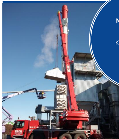
HEGI-2200 während der Montage
